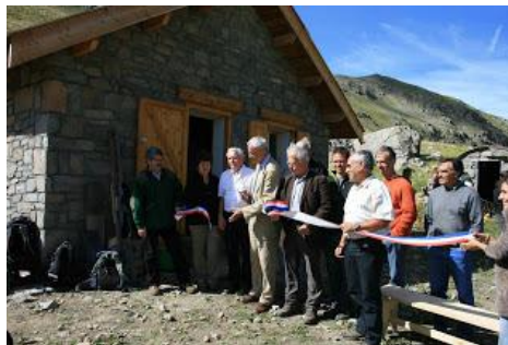
Photo 15 Inauguration de la cabane pastorale rénovée du vallon de Bouchiers (06)
