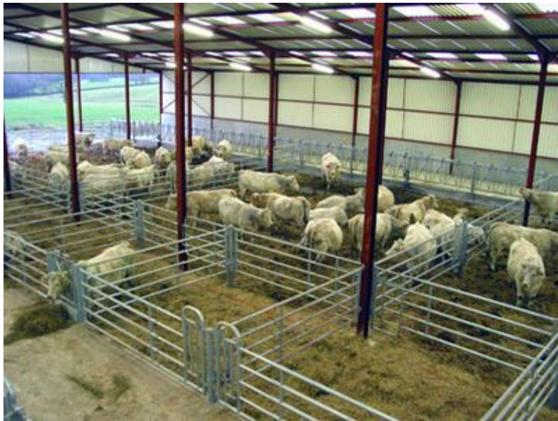
Photo 1 : Tubes et cornadis galvanisés présents en abondance dans les élevages bovins (Jourdain, 2013)
