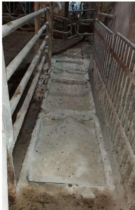
**Figure 11 - Les 3 pédiluves alignés dans le couloir de sortie (avant rectification du niveau d'argile)**
